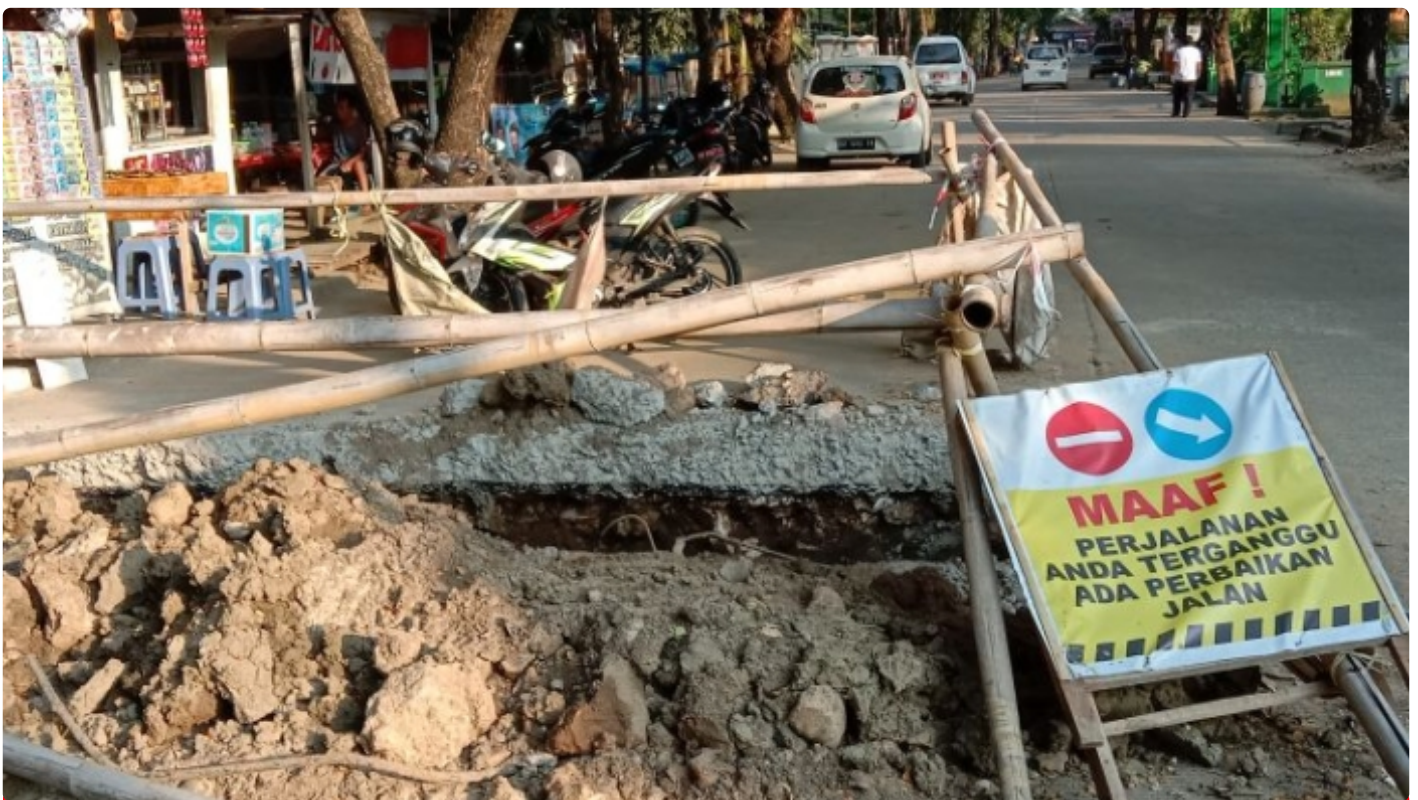
Jalan Cendana dibongkar dan belum dilanjutkan pekerjaannya
