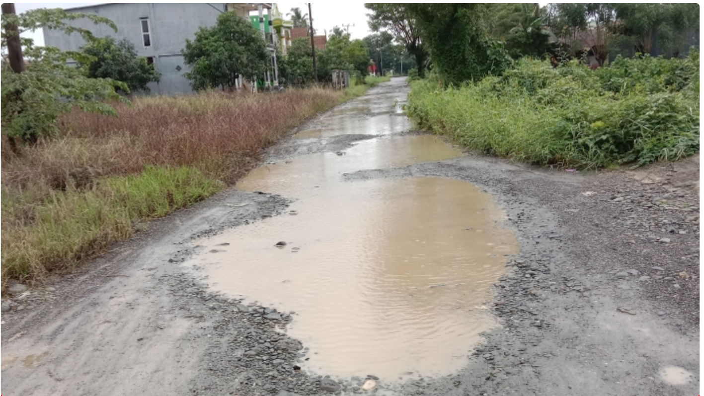
Jalan poros desa Benteng rusak parah
